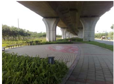
高架橋下雙柱配置中央穿越自行車道
