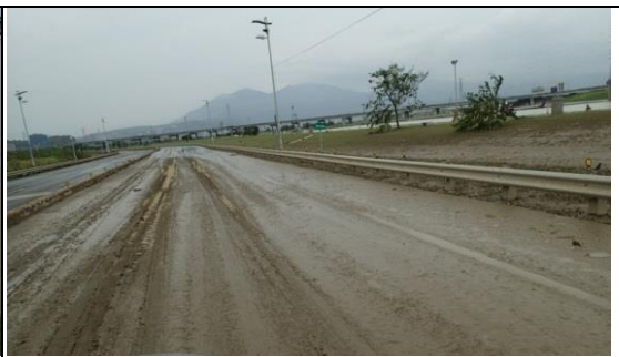
退水後道路淤泥沈積
